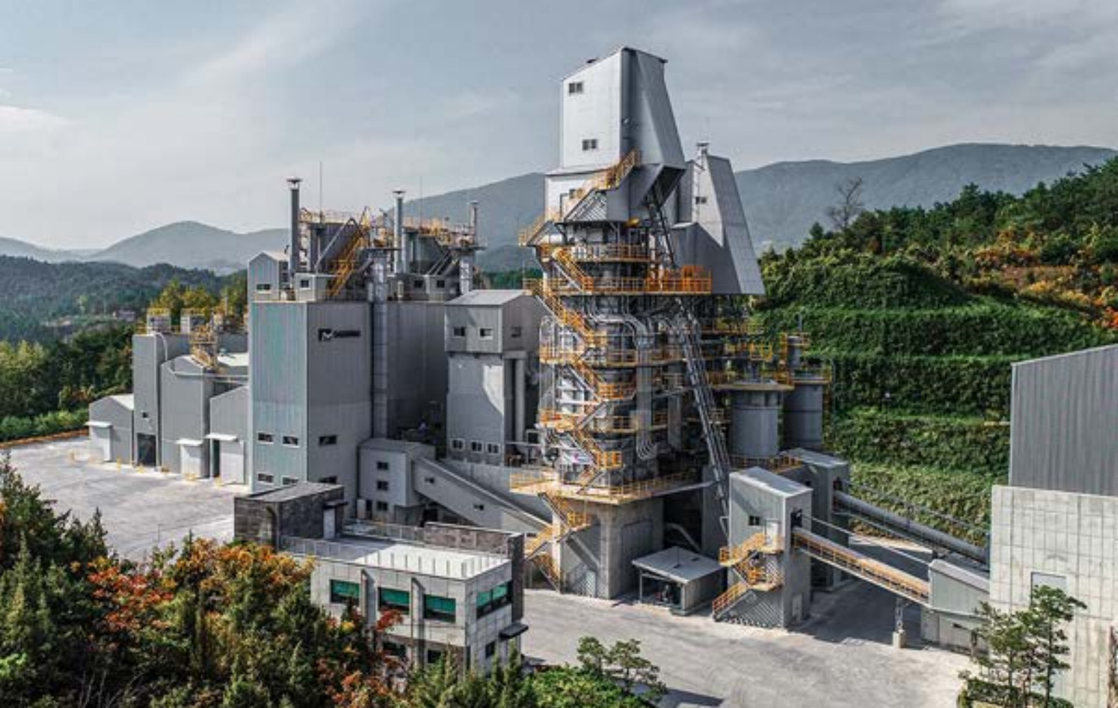
Šachtová pec MAERZ
