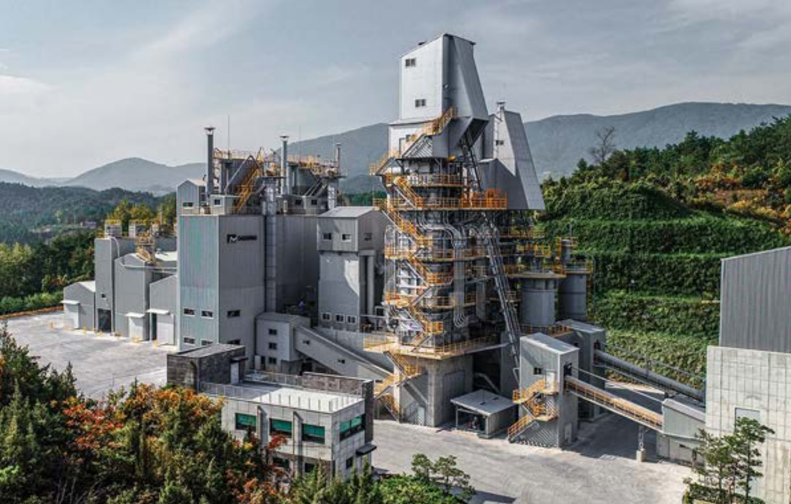
Šachtová pec MAERZ
